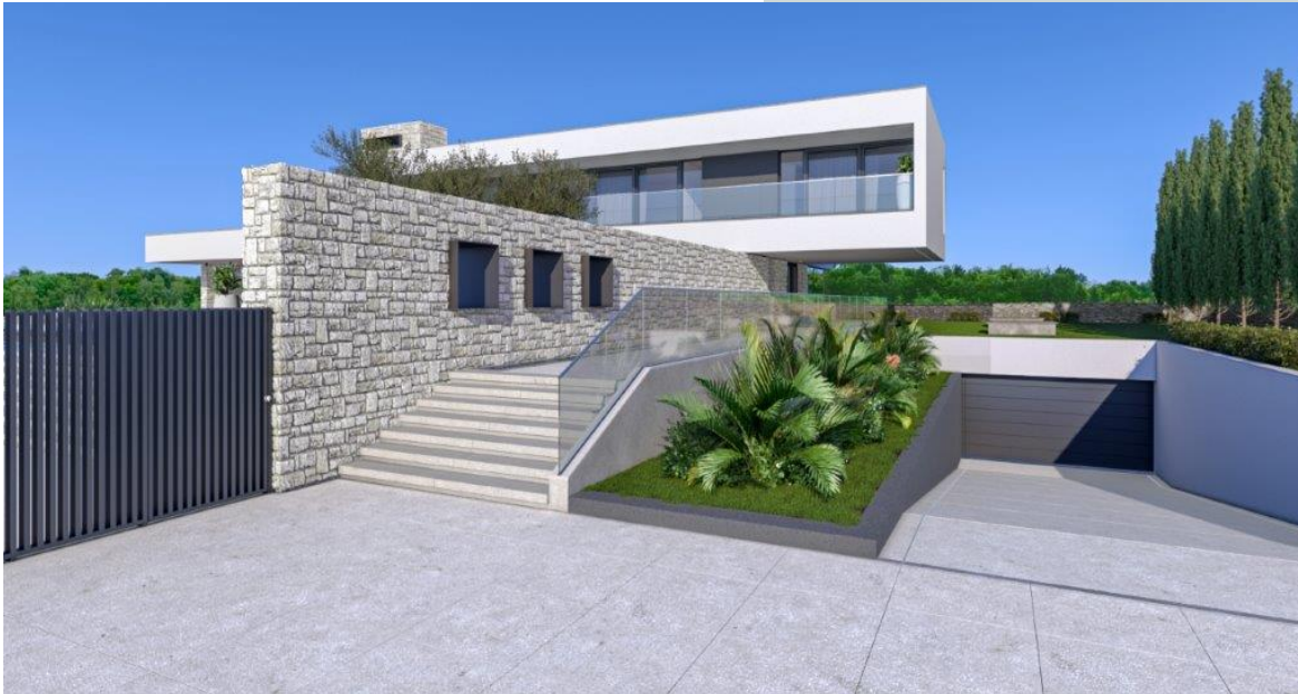
Južno pročelje, ulaz
