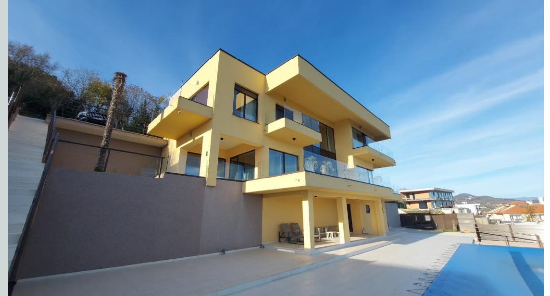
Izvedeno stanje, prije rekonstrukcije
