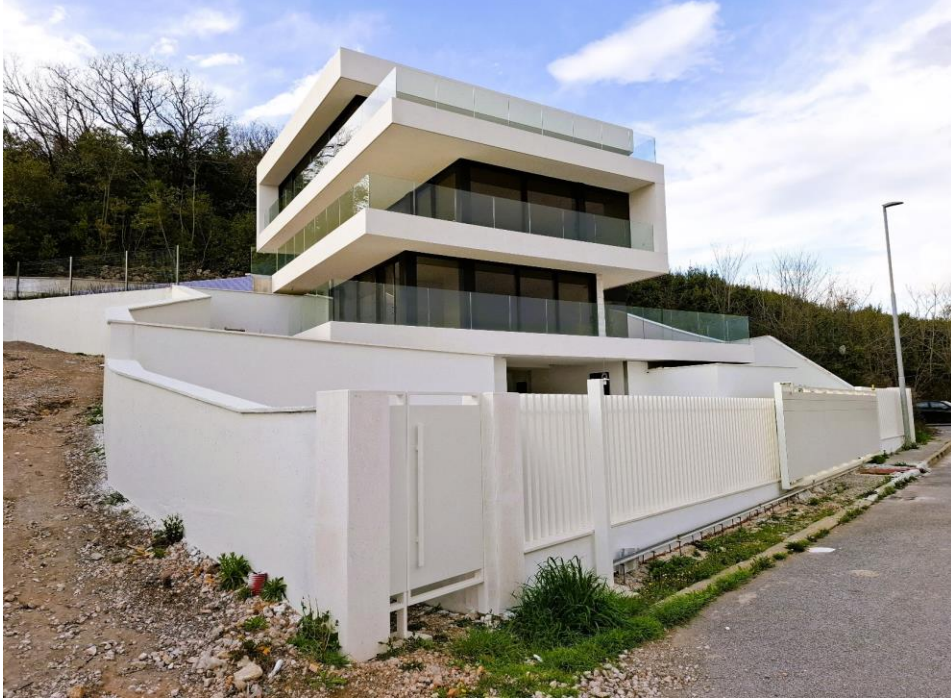
Radovi pri kraju, jugozapadno pročelje
