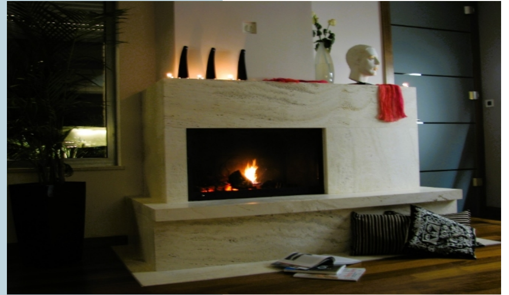
Kamin obložen talijanskim kamenom travertino
